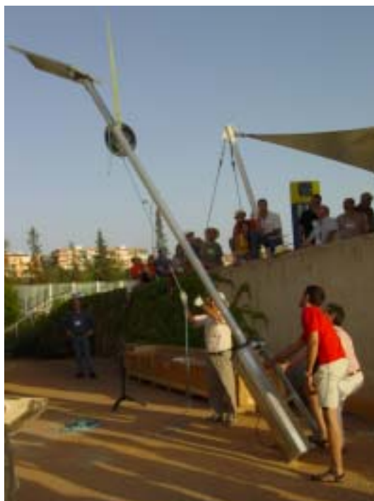
Levantamiento de una de las farolas solares durante el Encuentro Solar 2006.
