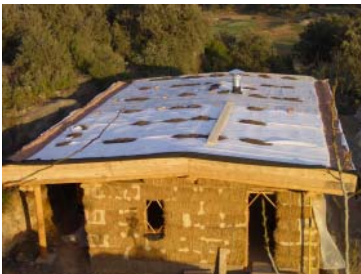
La construcción con balas de paja del proyecto LLUM DE SOL.
